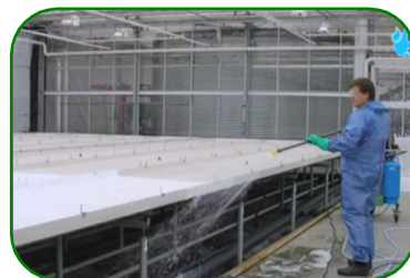
Links oben: Auszuglanze zur Behandlung des Energieschirmes. Rechts o.: Haftvermögen des Schaumes verlängert die Einwirkzeit.
